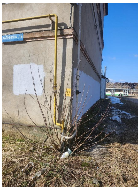
Фотографии ввода трубы газоснабжения в здание.
